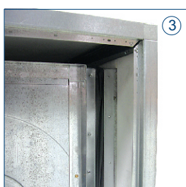
3 Uszczelnienie po stronie wylotu
