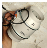
Przyłączenie przewodów zasilania
