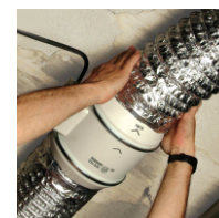
Montaż kanałów wentylacyjnych
